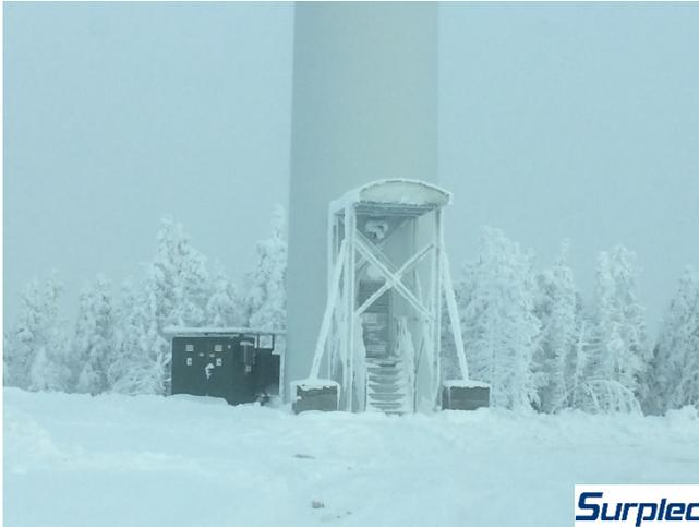
Figure 14 : Dispositif permanent pour protéger l'accès à l'éolienne des chutes de glace
