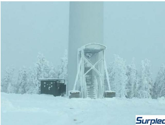
Figure 14 : Dispositif permanent pour protéger l'accès à l'éolienne des chutes de glace
