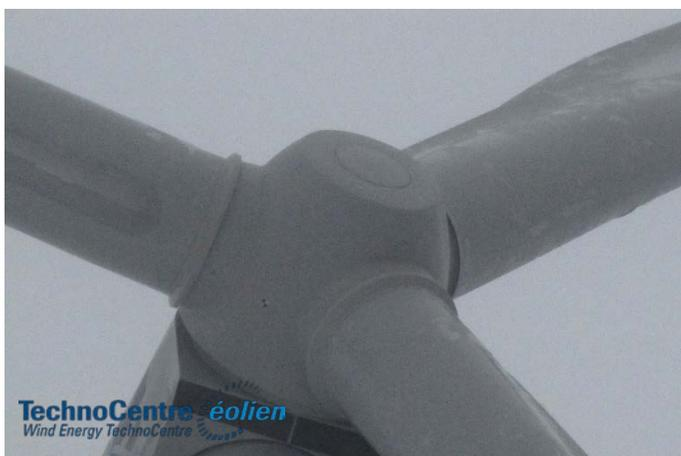
Figure 7 : Accumulation typique de verglas sur le rotor d'une éolienne
