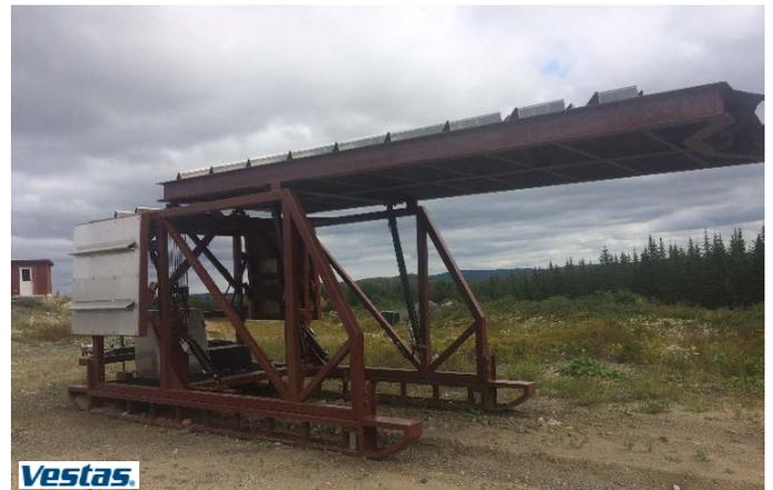
Figure 17 : Dispositif de protection contre les chutes de glace
