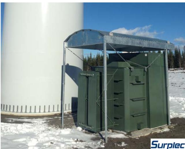
Figure 15 : Dispositif permanent pour protéger le transformateur contre les chutes de glace
